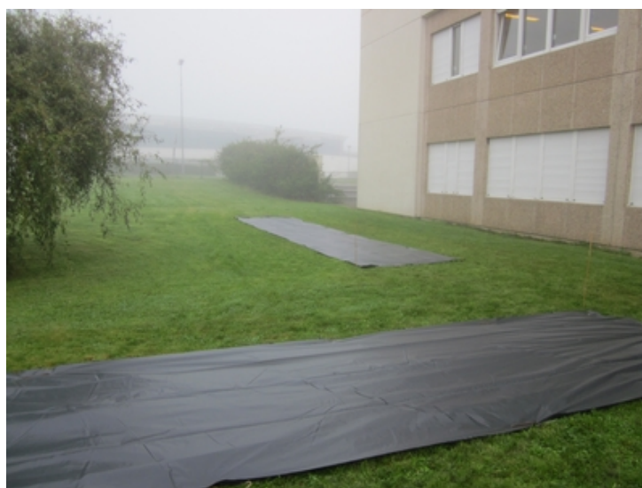
Mise en place de la bâche au mois d'octobre 2013
